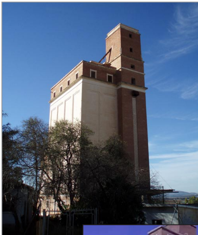
Silo de Antequera Construido 1953 Demolido 2010 Silo d'Antequera Construit en 1953 Démoli en 2010
