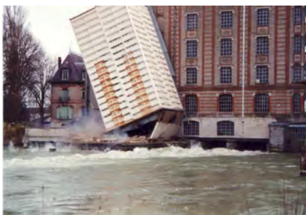
Démolition du bâtiment des « verres »
