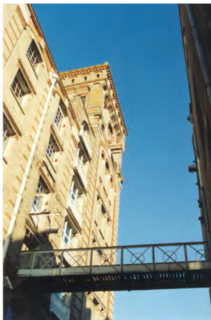
Passerelle aérienne reliant les moulins aux bâtiments de stockage de grains
