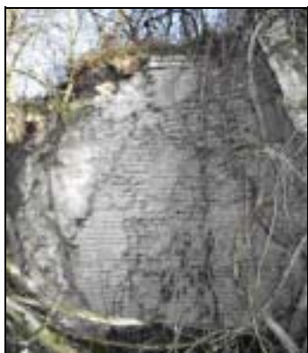
Les premiers fours construits en 1867
