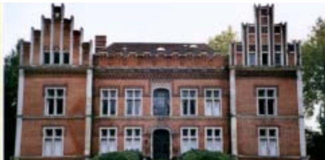
Le château patronal de l'usine Gilardoni, à l'abandon
